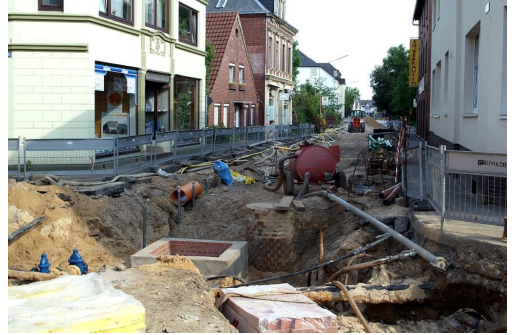
Sanierungsarbeiten in der Austraße 2005
